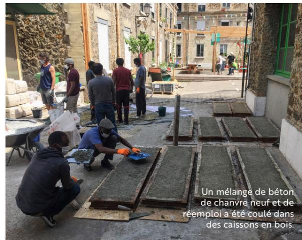
Un mélange de béton de chanvre neuf et de réemploi a été coulé dans des caissons en bois.
