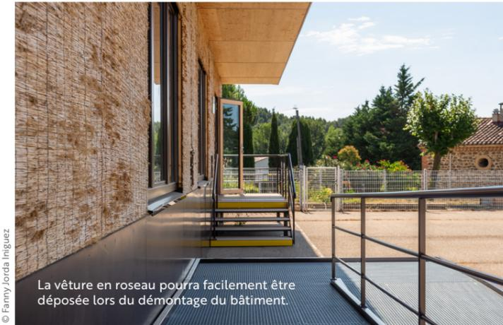
La vêtiture en roseau pourra facilement être déposée lors du démontage du bâtiment.
