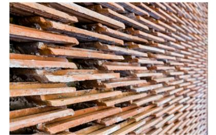
Cet appareillage en tuiles de réemploi est favorable pour une contre-cloison acoustique.
