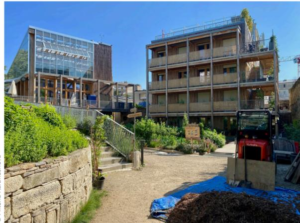
Les murs de soutènement, réalisés en pavés de réemploi, forment des jardins en terrasse qui relient naturellement le niveau bas (rue de l'Ourcq) et le niveau haut (Petite Ceinture).
