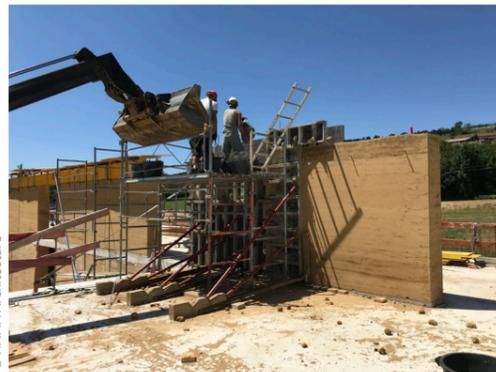
Le mur en terre crue non stabilisé (sans ciment ni chaux) a été damé sur site.
